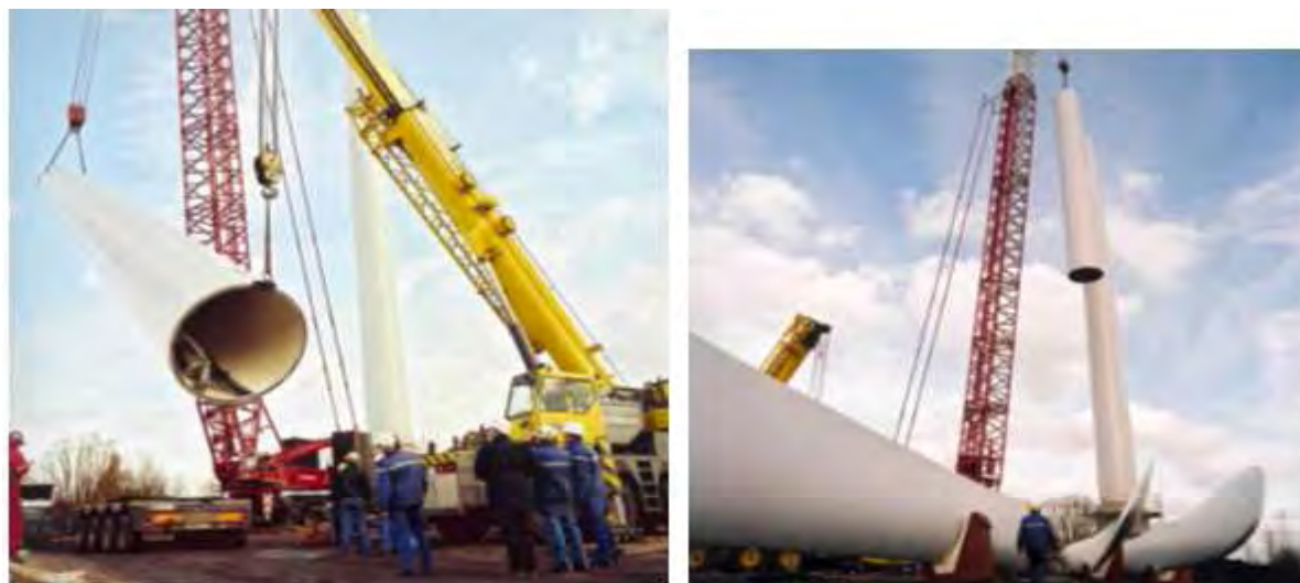
Illustration 2 : Érection du mât d'une éolienne de Schelle (photo : Electrabel SA).
