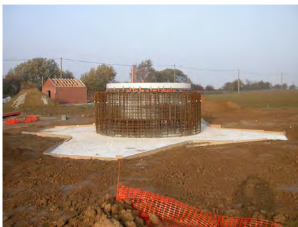
Illustration 1 : Terrassement et armature de la fondation d'une éolienne de Perwez (photo : Air Energy).
