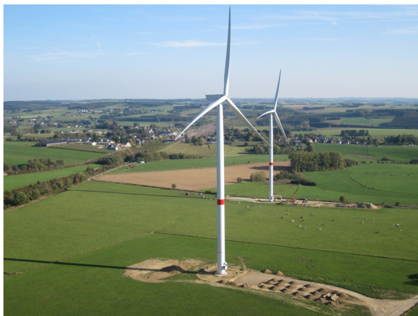
Photo 2 : Photo d'éolienne type semblable au modèle N90 (machine Nordex N100/250 parc éolien existant de Gouvy, Province de Luxembourg)
